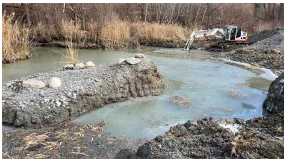
Baggerarbeiten für den neuen Teich
